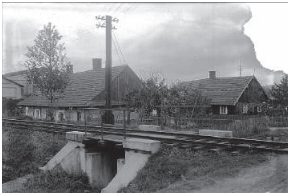
Mostek kolejowy przy ul. Krzywej.
