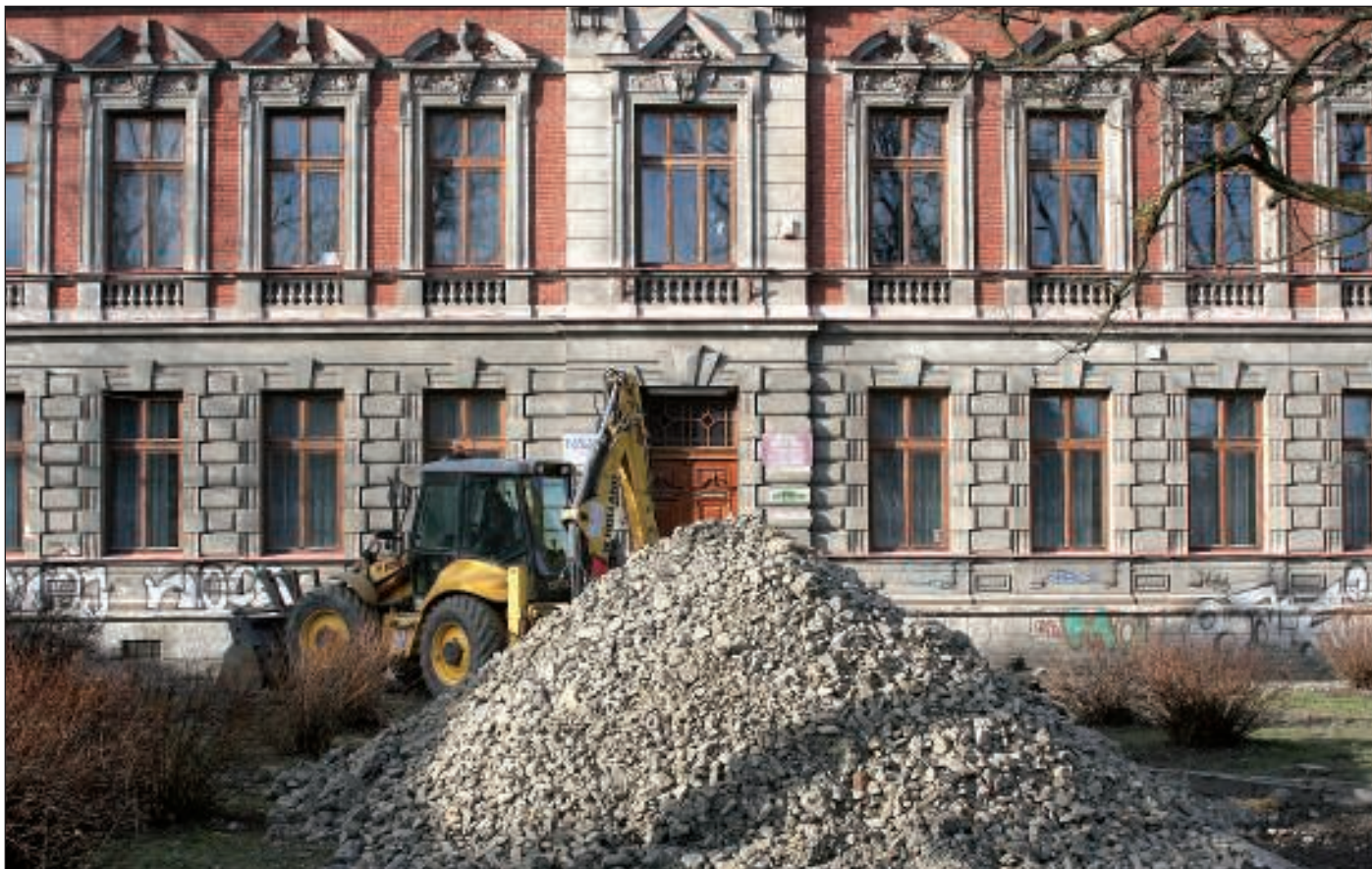
Trwa remont „starej szkoły”. Do biblioteki, TBS-u, redakcji oraz punktu ubezpieczeń i ZUS wchodzimy od ul. A. Brody. Fot. W. Suchta
