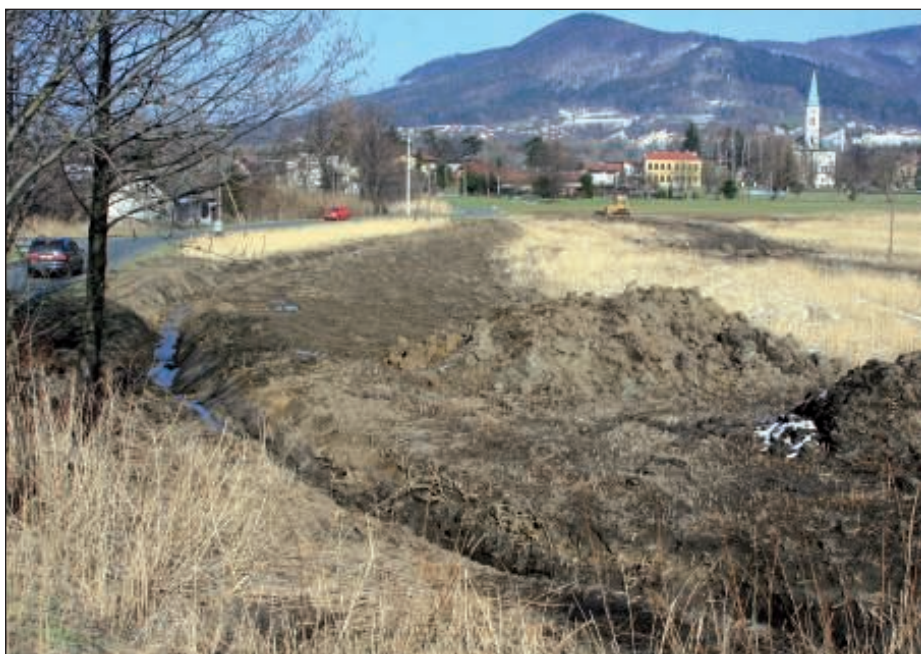
Odtwarzanie systemu melioracyjnego.
