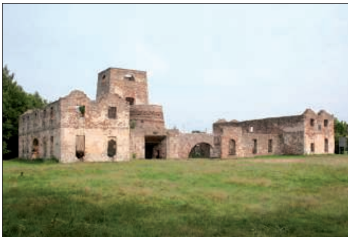
Zespół budynków administracyjno – przemysłowych Huty Józef w Samsonowie, zachowanych w postaci trwałej ruiny.
