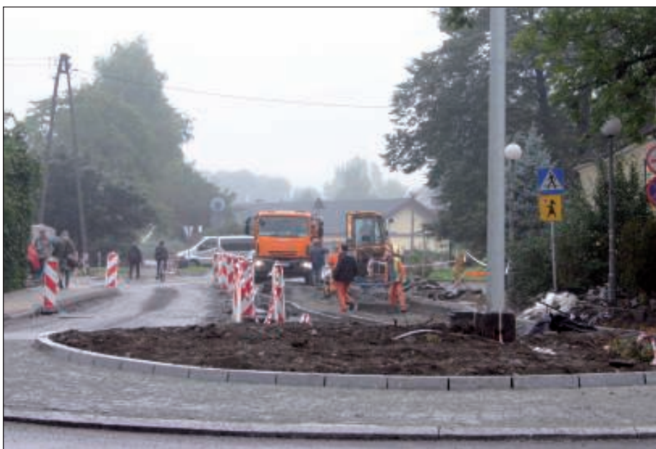
Przebudowa skrzyżowania przy „dwójkach” zakończy się we wrześniu.
