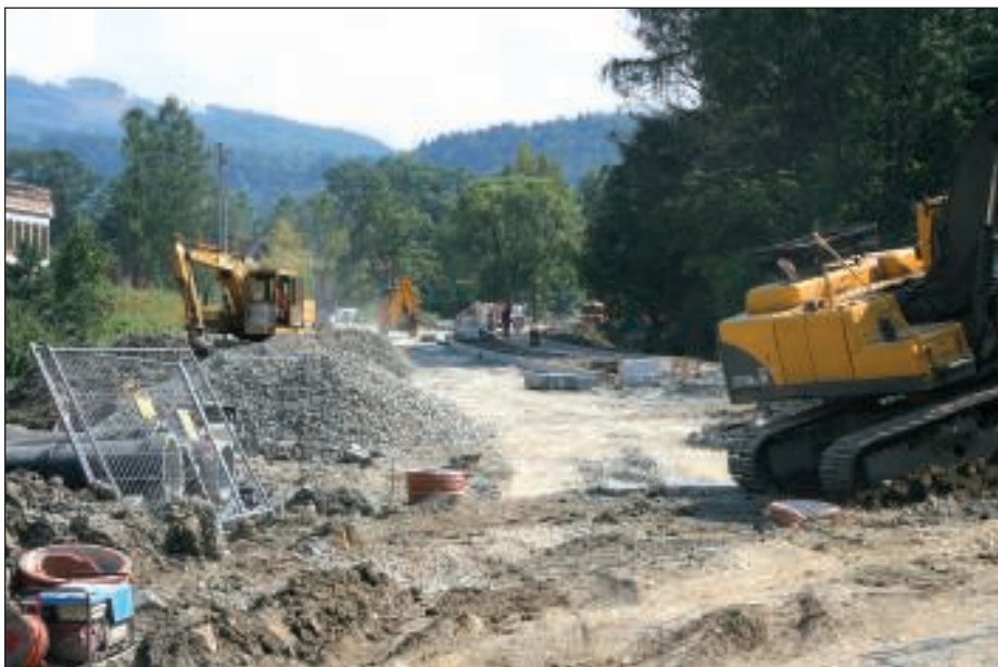
Drogą pod skarpą będziemy jeździć od października.
