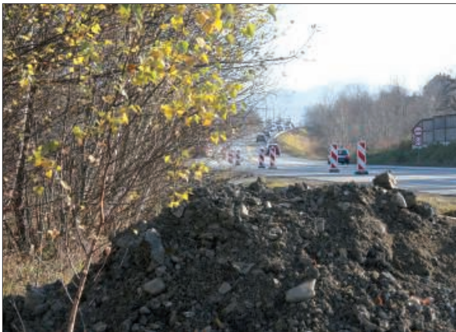
Trwają roboty ziemne.
