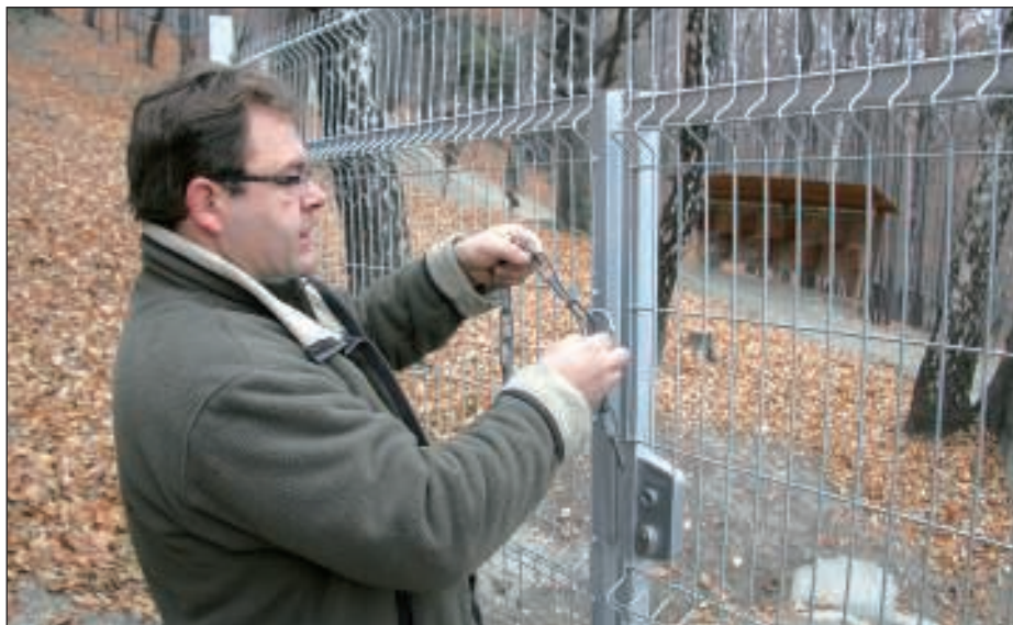
P. Machnowski przy nowym ogrodzeniu.
