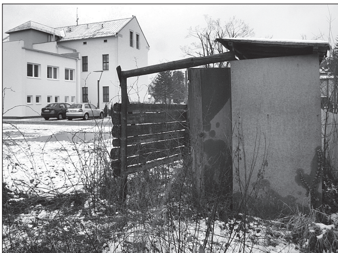
Z satysfakcją spoglądamy z okien redakcji na ten przybytek, wiedząc że w przypadku awarii WC mamy kabinę zastępczą. Fot. W. Suchta
