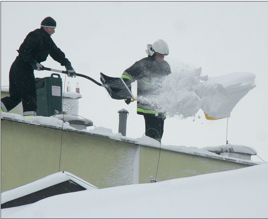
Odśnieżanie dachu sali gimnastycznej SP-2.
