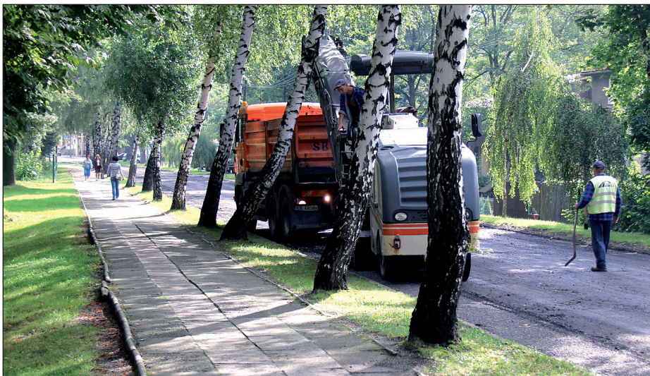
Trwa remont ul. Partyzantów. Zakres robót to rozbiórka chodnika i nawierzchni jezdni, budowa kanalizacji deszczowej, położenie nowej nawierzchni i budowa chodników, montaż barierki przy szkole i znaków drogowych. Należy spodziewać się utrudnień w ruchu i objazdów. Roboty potrwać do połowy listopada. Koszt to 1.120.000 zł, a wykonawcą jest grupa kapitałowa WONAM z Pszczyny.
