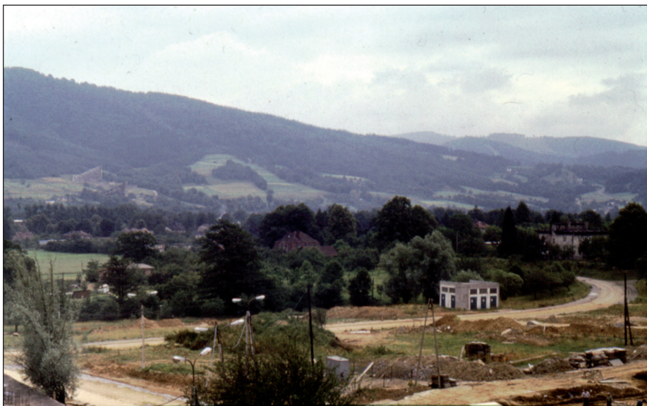
Zdjęcie pochodzące z okresu budowy wykonane z budynku nr 1 w 1977 roku.
