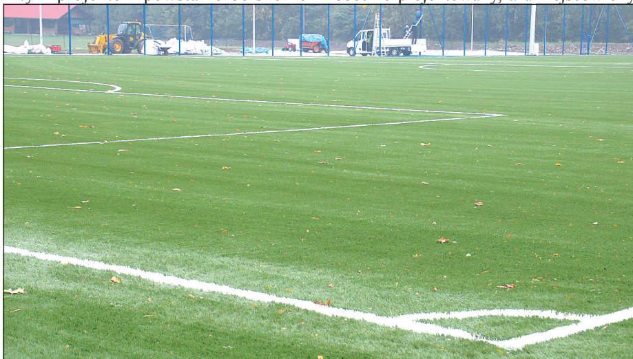
Boisko ze sztuczną trawą już na ukończeniu.
