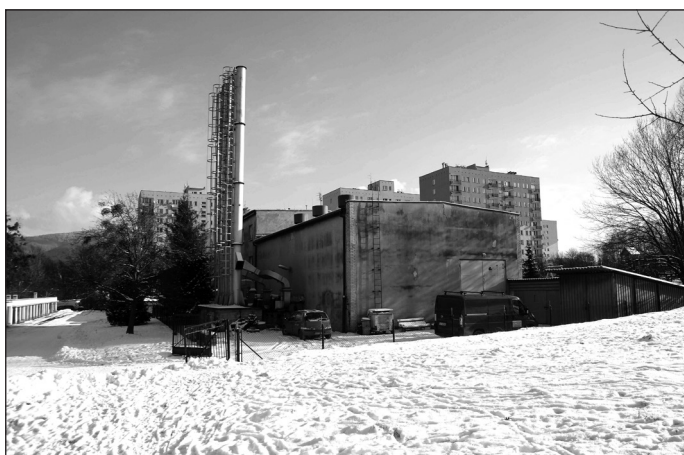
Kotłownia czeka na modernizację.
