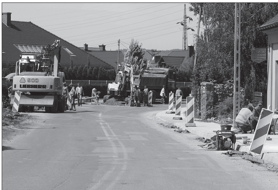
Trwa remont ul. Skoczowskiej.
