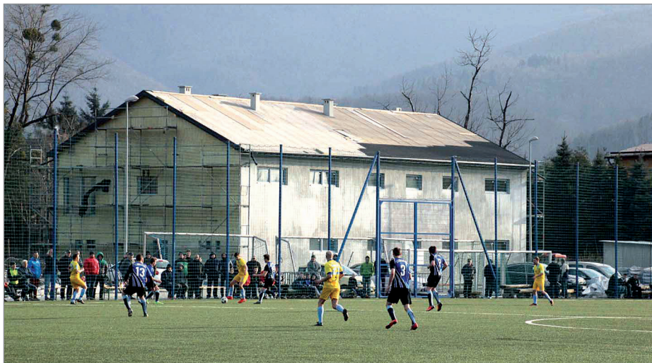
Za boiskiem postawiony jest budynek zaplecza techniczno-socjalnego. Obecnie trwają prace wykończeniowe. Fot. W. Suchta
