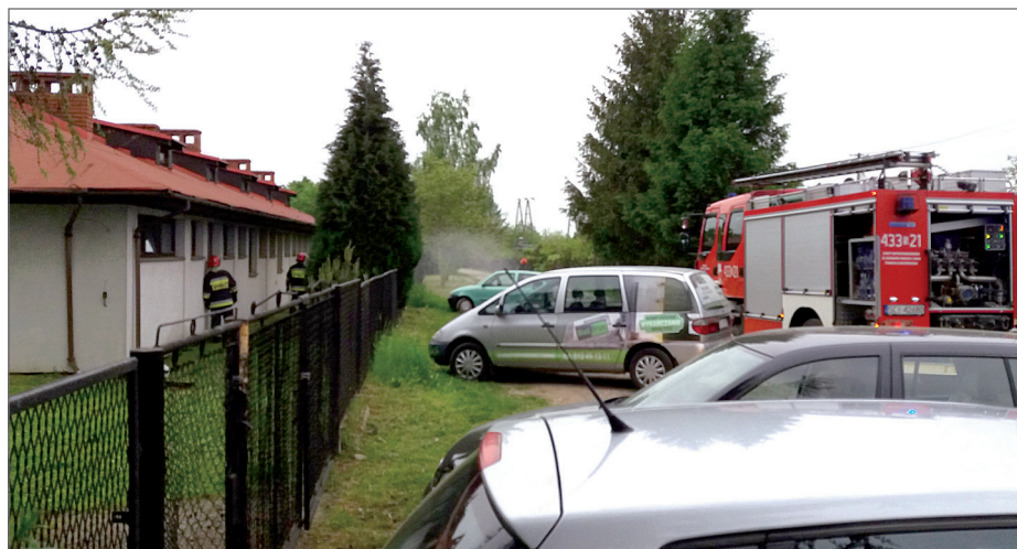
Przy parafii pw. Matki Bożej Królowej Polski w Hermanicach w sobotni wieczór zaczął ulatniać się gaz. Stwierdzono uszkodzone przyłącze gazowe spowodowane korozją i złym zabezpieczeniem. Strażacy zabezpieczyli otwór opaską zaciskową oraz kurtyną wodną. Następnie, sprawę przekazali pracownikom pogotowia gazowego.
