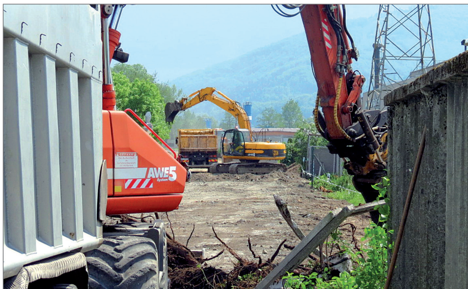
Rozpoczął się remont ul. Sportowej.
