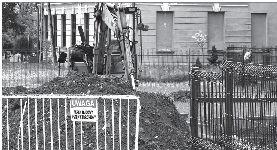
To jeszcze nie budowa kompleksu basenowego, ale powstała już spółka Ustrońskie Termy, która inwestycję zrealizuje.
