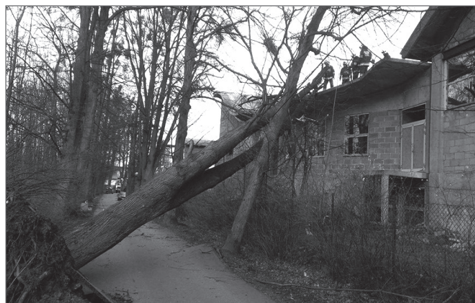
Szkody nad Wisłą.
