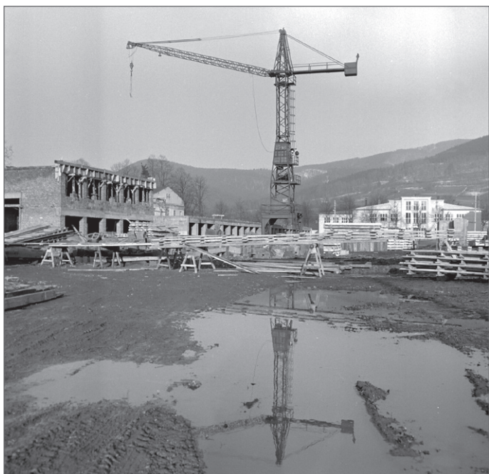
Budowa Szkoły Podstawowej nr 1.
