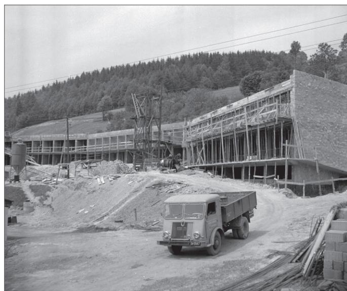
Budowa Domu Nauczyciela.
