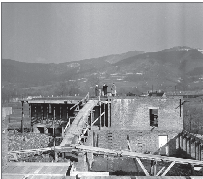
Budowa Wytwórni Wód Gazowanych „Czantoria”.
