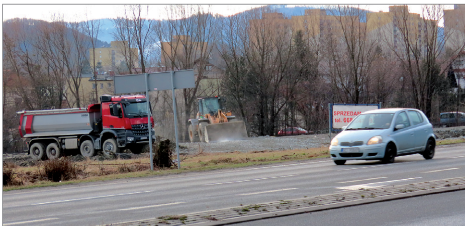
Trwają prace ziemne przy dwupasmowce naprzeciwko Tesco, jednak na razie do Urzędu Miasta Ustroń nie wpłynęła informacja o wydanym pozwoleniu na budowę w tej lokalizacji. Fot. M. Niemiec
