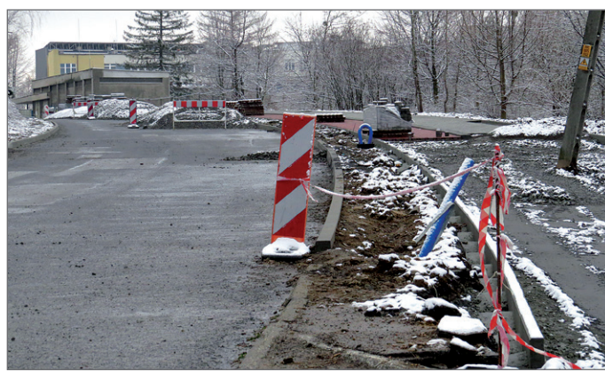
Rozpoczął się 2 etap remontu ul. Szpitalnej. Koszt inwestycji to ok. 2 mln 100 tys. zł. Fot. A. Jarczyk
