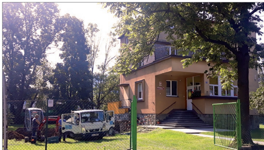
Po wyłonieniu wykonawcy z wolnej ręki remont w Przedszkolu nr 1 jednak się rozpoczął, ale w takim zakresie, żeby nie zakłócać pracy placówki. Prace obejmą m.in. modernizację kotłowni i ocieplenie fundamentów. Fot. M. Niemiec
