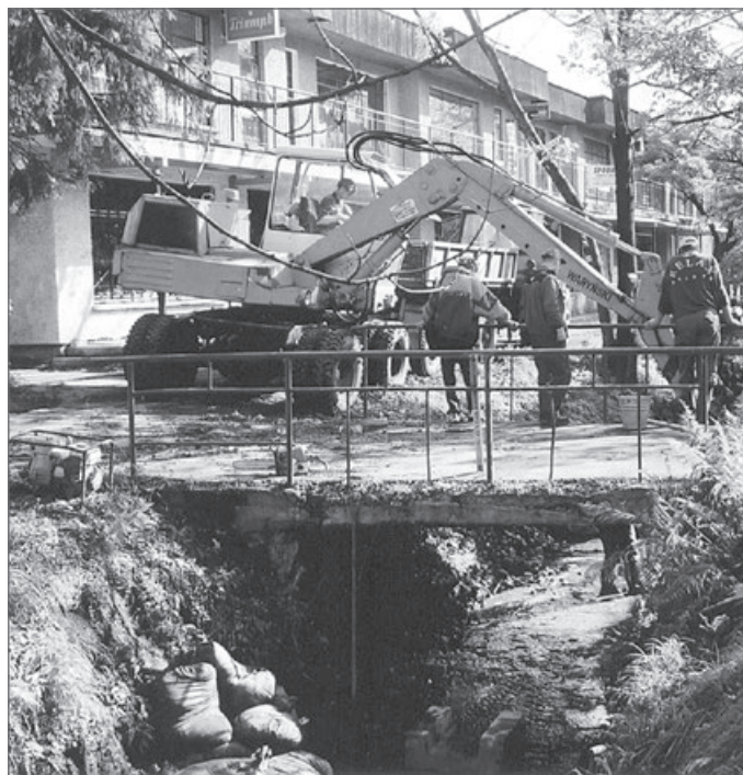
Betonowanie Bładniczki rozpoczęło się w 2000 r. Fot. M. Niemiec
