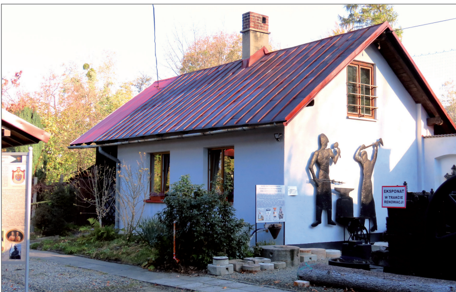
Domek został wybudowany ok. roku 1890 r.
