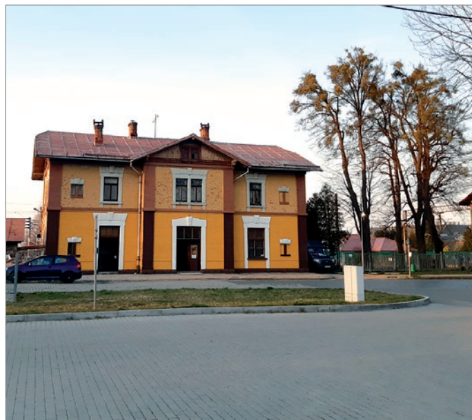
Remont dworca otwartego 18 grudnia 1888 już się rozpoczął, a ze ścian budynku zniknęły szpecące go graffiti. Fot. K. Francuz
