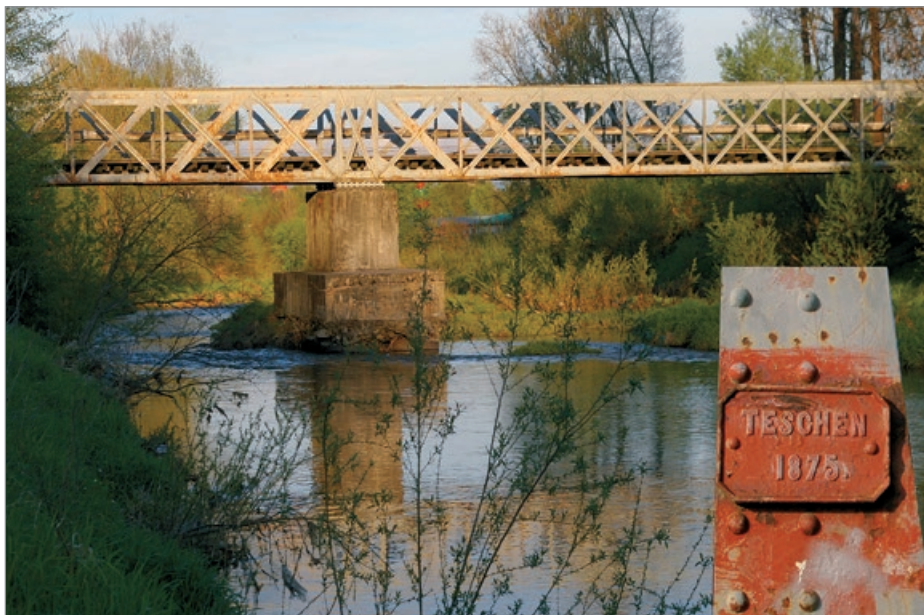
Most w Libuszy z tabliczką znamionową - ustroniskie wyroby znakowano charakterystycznym, prostym liternictwem. Uwagę zwracają słynne ustroniskie nity.
