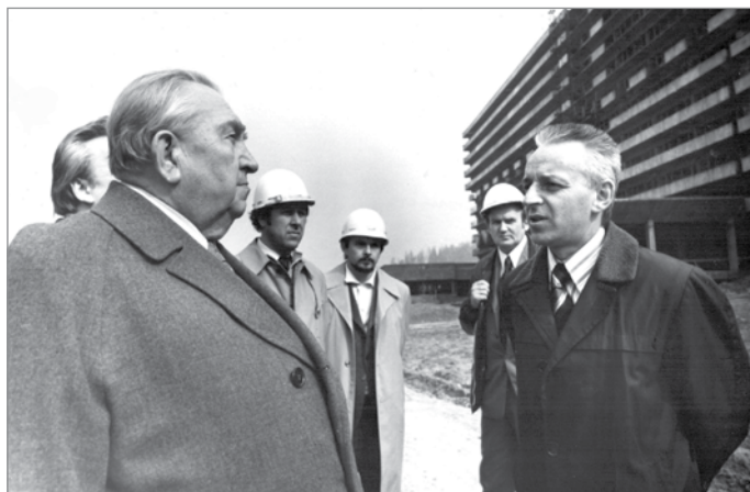
Wizyta gen. Jerzego Ziętka w Ustroniu Zawodziu. Budowa Sanatorium i Szpitala Uzdrawiskowego Równica, pierwsza połowa lat 70. XX w. Od lewej: Jerzy Ziętek, Zdzisław Toporek, nn, Antoni Plaskura, Korneliusz Świętek.
