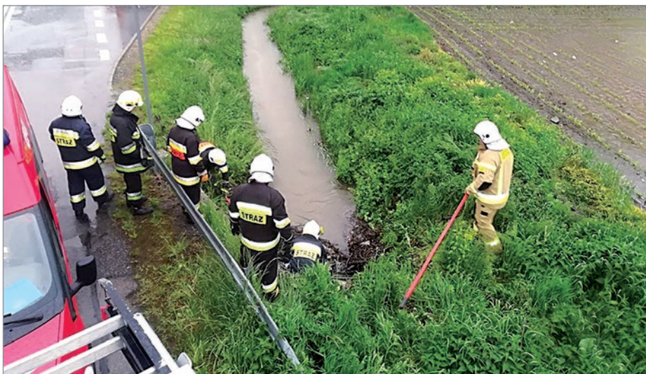
Udrożnienie zatoru na cieku wodnym, ul. Zabytkowa.
