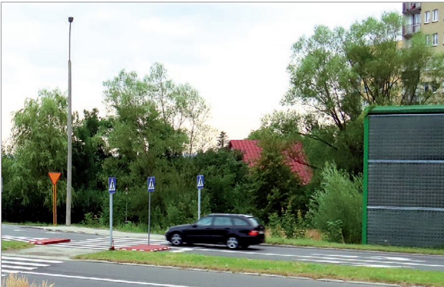
Przed przejściem dla pieszych mamy już tylko jeden pas ruchu.
