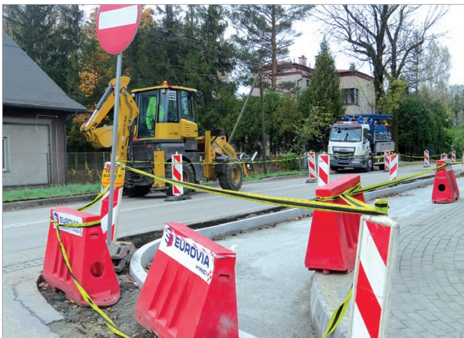
Prace remontowe na ul. Cieszyńskiej będą trwać do końca listopada. Fot. L. Szkaradnik
