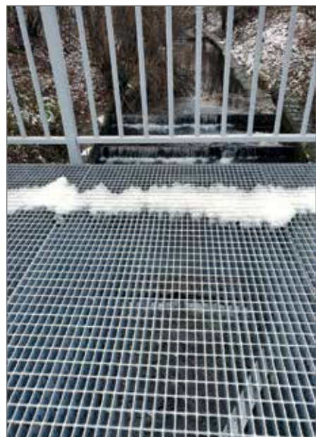
Kolejna inwestycja zakończona. 11 grudnia oddana została do użytku kładka pieszo-rowerowa nad potokiem Dobka, na ul. Złocieni. Ma długość 15 m, szerokość 3 m.
