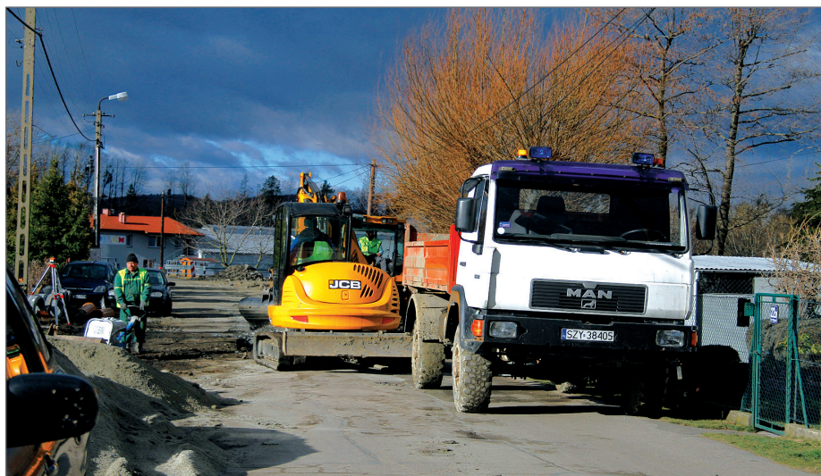
Rozpoczął się remont ul. Fabrycznej, a wraz z nim utrudnienia w ruchu. Fot. K. Francuz
