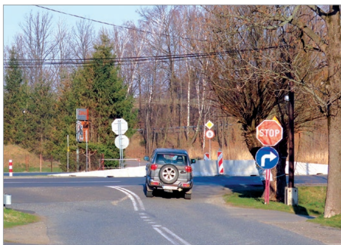
Skrzyżowanie zamknięto w marcu 2020 roku.
