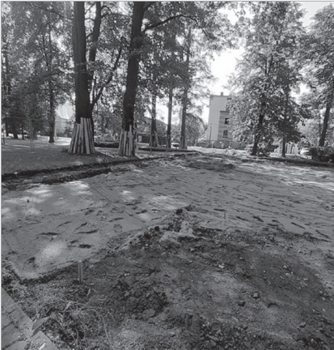
Budowa tężni w Parku Kuracyjnym.
