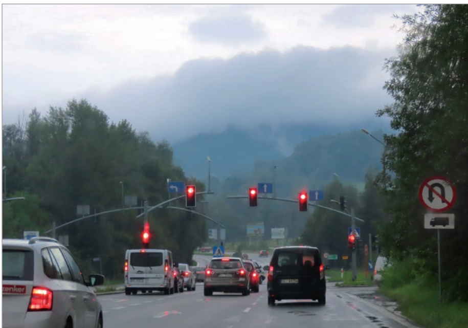
Przebudowa ma się zacząć za skrzyżowaniem z ul. Cieszyńską.
