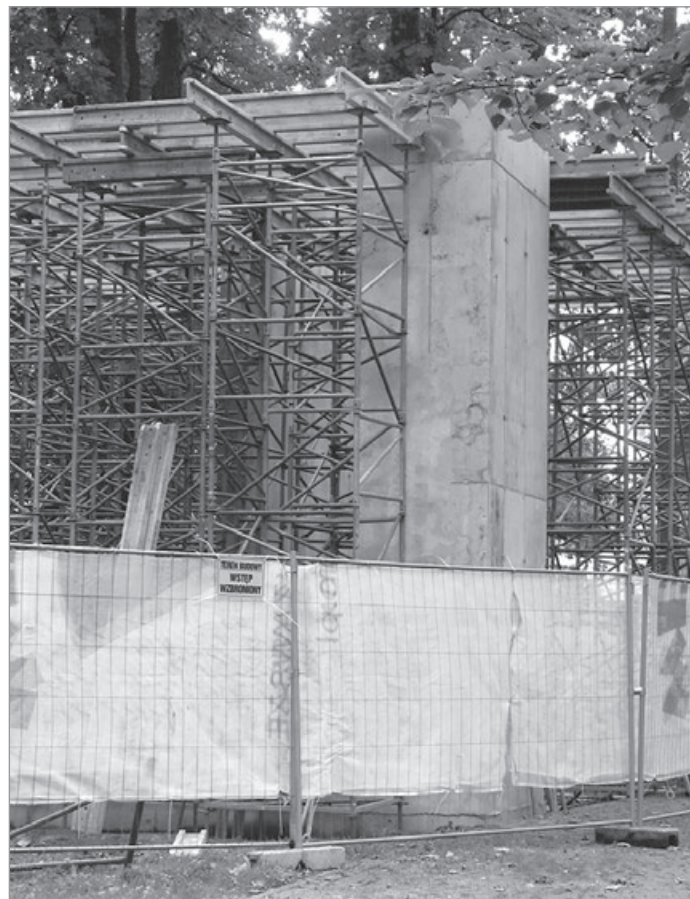
Trwa budowa tężni w Parku Kuracyjnym.
