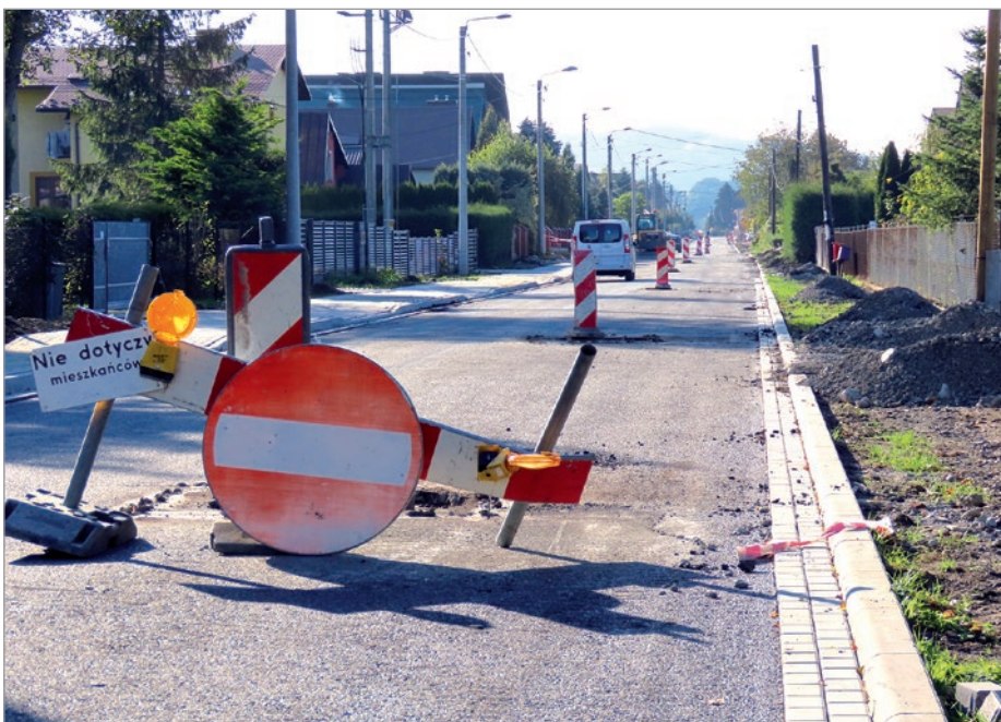
Trwa remont ul. Bładnickiej.
