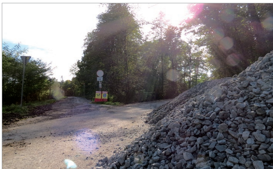
W lutym 2021 r. Miasto Ustron podpisało umowę z wykonawcą na modernizację trasy rowerowej łączącej miasto Ustron z gminą Brenna i gminą Wisła realizowanej w ramach zadania inwestycyjnego pn.: „Rowerem przez Beskidy – etap I”. W tym roku zostały rozpoczęte roboty budowlane, które będą kontynuowane do końca 2022 r. Na zdjęciu parking przy ulicy Wiklinowej w Nierodzimiu, gdzie trwają prace i gromadzone są materiały niezbędne do budowy ścieżki.
