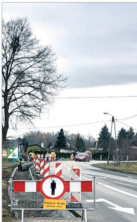
Kierowcy uważać muszą na częściowe zwężenie jezdni związane z utwardzeniem pobocza. Fot. D. Walker
