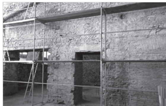
Łukowato zwieńczone przejścia w ścianach dawnej huty, odsłonięte podczas remontu szkoły.
