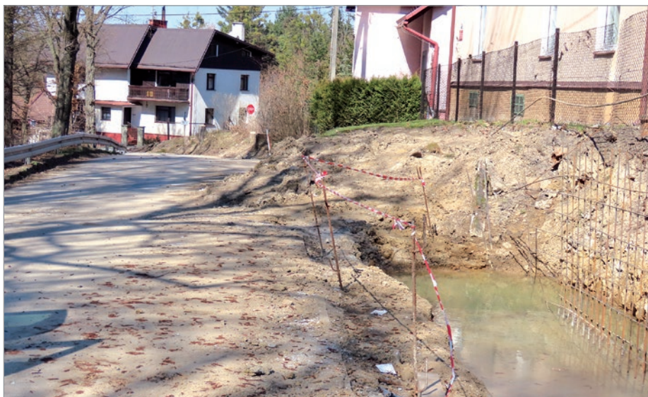
Remont ma się skończyć w październiku.
