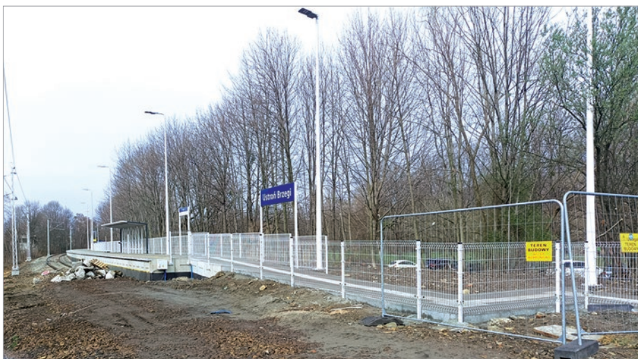
Nowy przystanek kolejowy na Brzegach już prawie gotowy.
