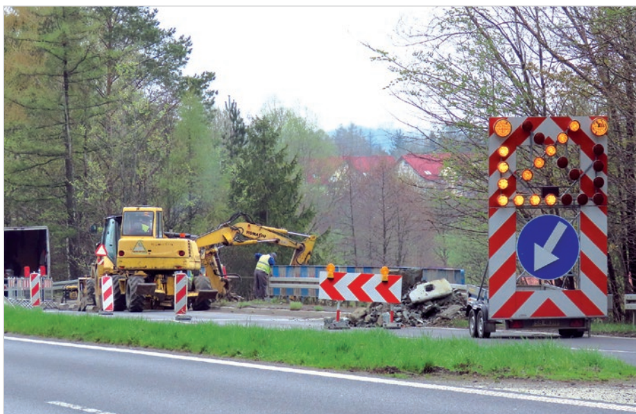
Trwają prace remontowe na drodze wojewódzkiej. Odnawiane jest tzw. oznakowanie poziome, czyli linie na jezdni. Kierowcy czekają na naprawę nawierzchni, bo w niektórych miejscach jest w bardzo złym stanie, np. na środku skrzyżowania ul. Cieszyńskiej z ul. Katowicką. We wtorek były utrudnienia w ruchu na dwupasmówce, gdyż remontowano wiadukt. Na wysokości cmentarza komunalnego w kierunku Skoczowa ruch odbywał się jednym pasem.
