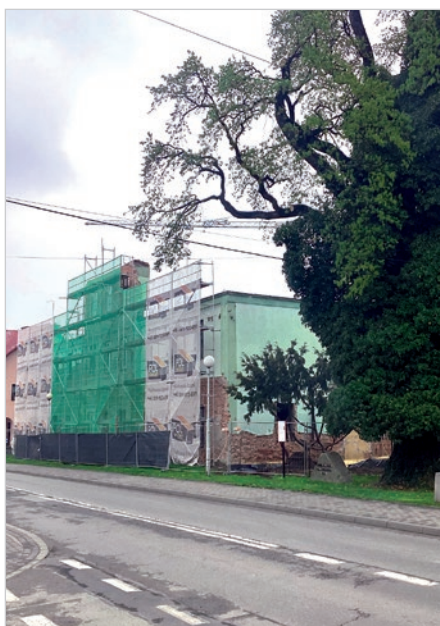
Przebudowana Donatówka zostanie oddana do użytku w przyszłym roku. Fot. M. Bieleś
