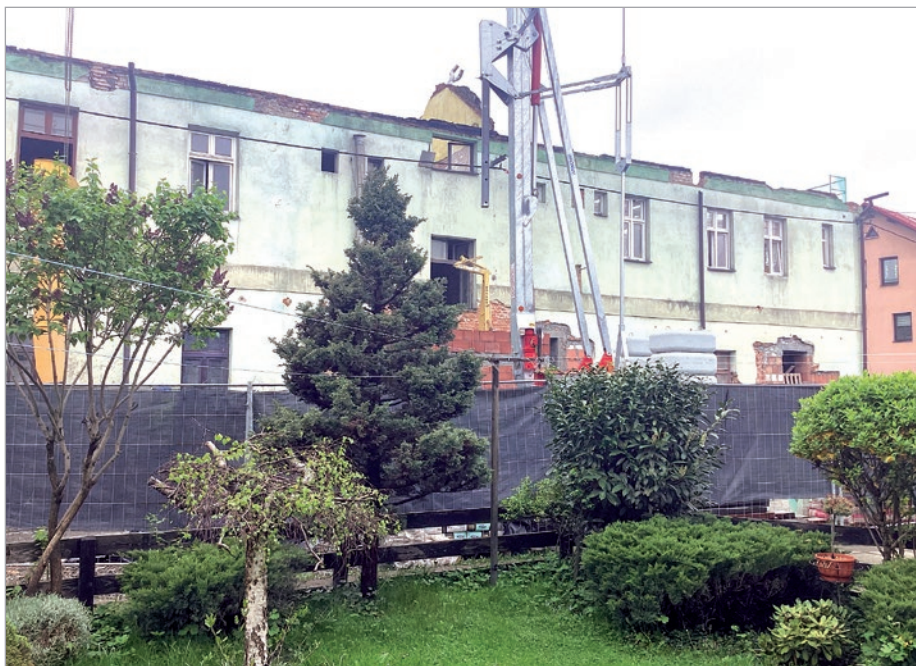
Gołym okiem widać skalę remontu.
