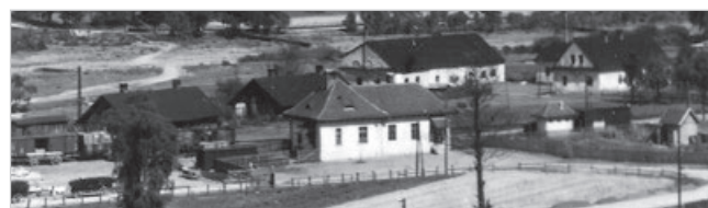
Na pierwszym planie dworzec kolejowy w Polanie, w tle wszystkie zabudowania, pozostałe po Kuźnicy „Teresy” - od prawej: dwa budynki administracyjno-mieszkalne, gmach papierni (później kuźnicy), dwa domy dla robotników (wówczas jeszcze drewniane)
