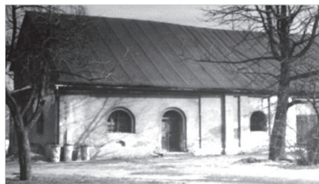
Budynek dawnej papierni od strony zachodniej.
