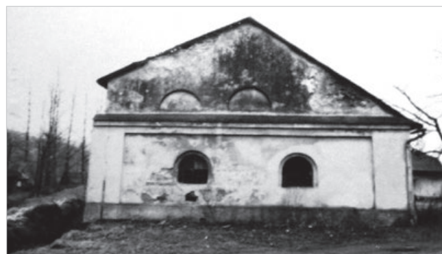
Zabytkowy obiekt papierni od strony północnej, z lewej widoczny kanał boczny, prowadzący wodę na turbinę Francisca.
