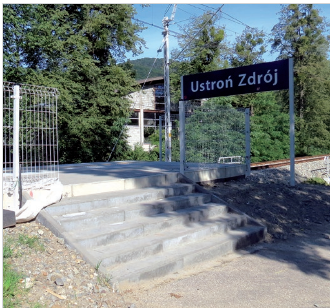
Wejście na peron od ul. Mickiewicza jest już gotowe.
