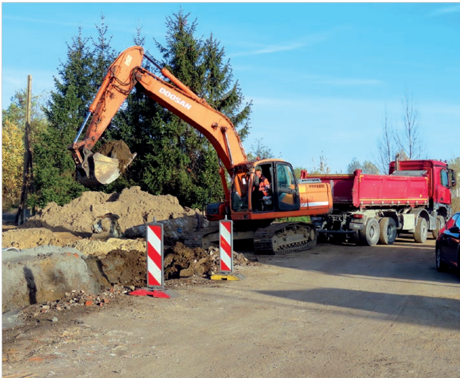
Obecnie w rejonie ul. Kozakowickiej prowadzone są prace ziemno-kanalizacyjne. Fot. M. Niemiec
