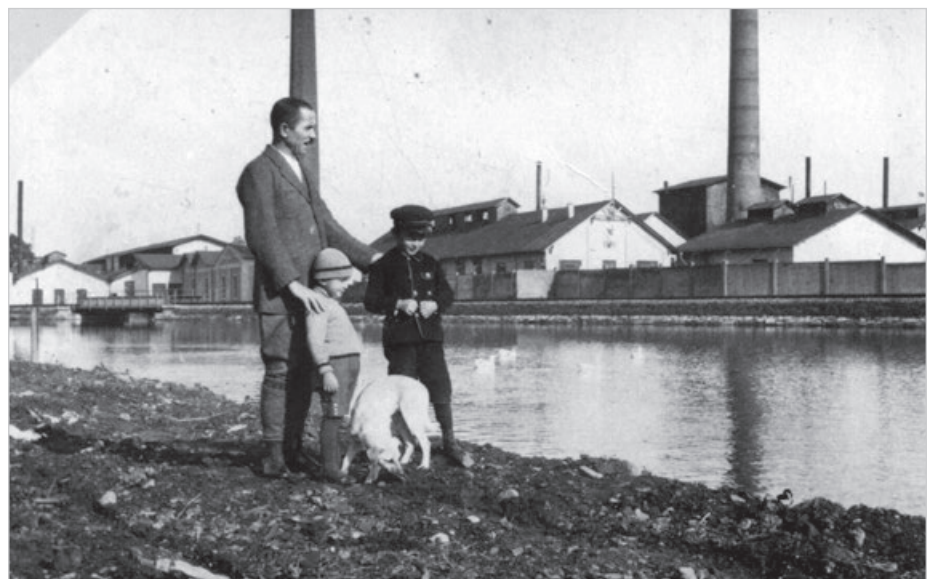
Rybak fabryczny Karol Cholewa z synami: Karolem (z prawej) i Janem. Nad stawem, w tle, widzimy od lewej: transformatorownię i warsztat elektryczny, starą kuźnię, maszynownię (warsztat instalatorów) i kotłownię. (z arch. Nelly Tomaszek)
