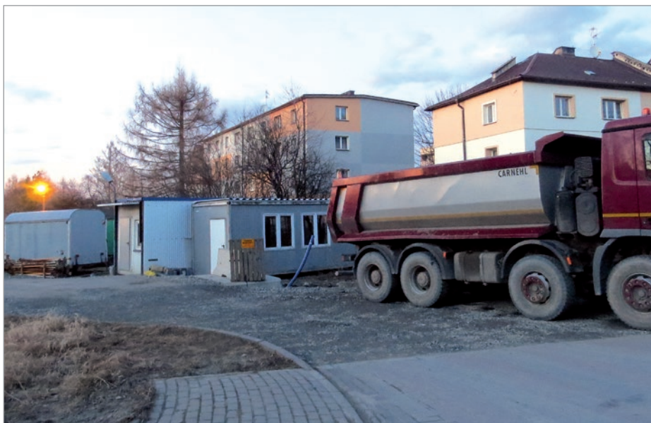
Przy ul. Cieszyńskiej trwa budowa dwóch domów mieszkalnych wielorodzinnych. Inwestorem jest firma „Arson” z siedzibą w Katowicach. Fot. L. Szkaradnik
