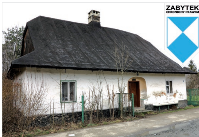
Stan zachowania obiektu 2023 r.
