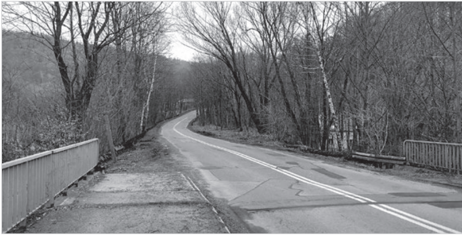
Modernizowana będzie ul. Skalica.
